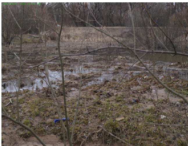
Рисунок 2.3. – Выпуск КЛК по ул. Карабановская, 41б на пойму р.Дубровенка (выпуск КЛК на пойму реки находится в низине, которая периодически подтапливается).
