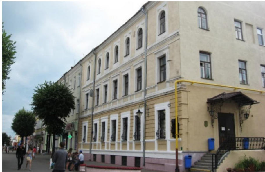
Будынкi па вул. Ленiнскай, 22, 20
