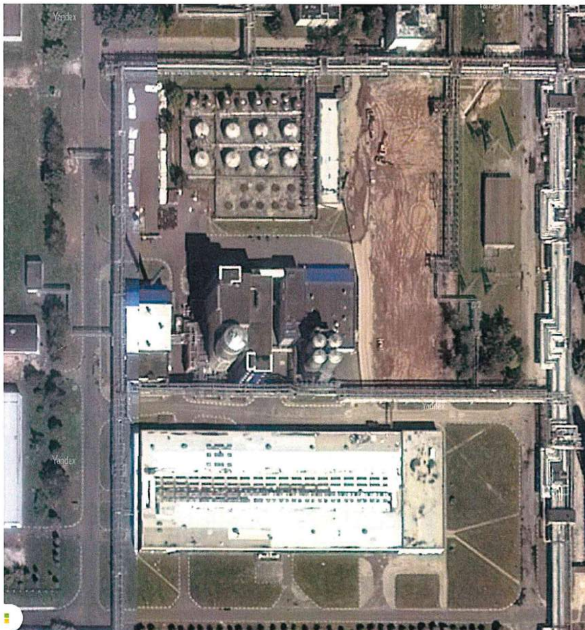
Рисунок 1.2 – Площадка строительства объектов первой очереди строительства
