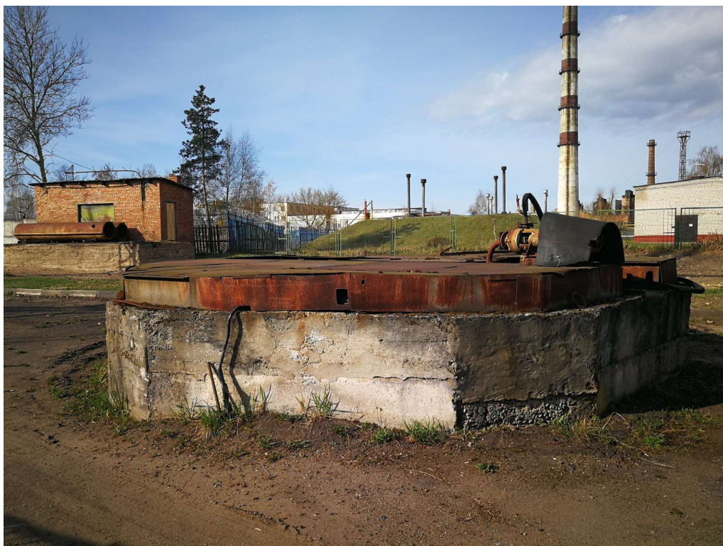
Рисунок 2.5 – Существующий аккумулирующий резервуар
