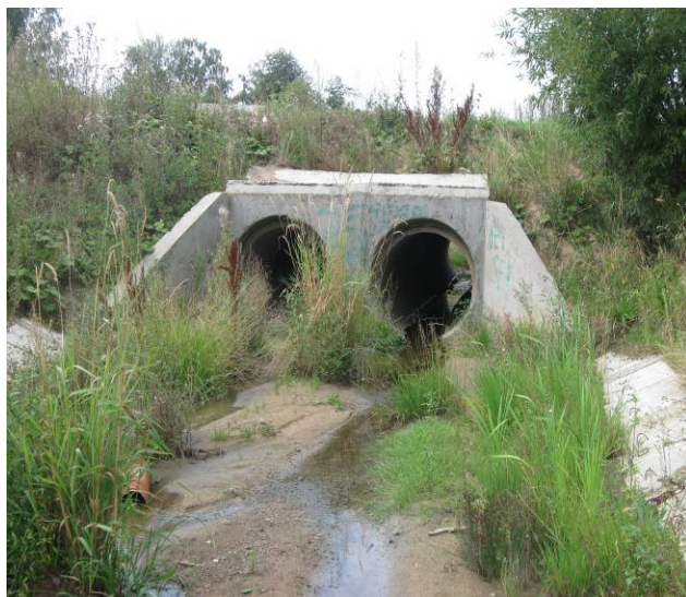
Рисунок 3.7 – Двухочковая железобетонная труба в створе пересечения ул. Калиновского и руч. Приснянский
