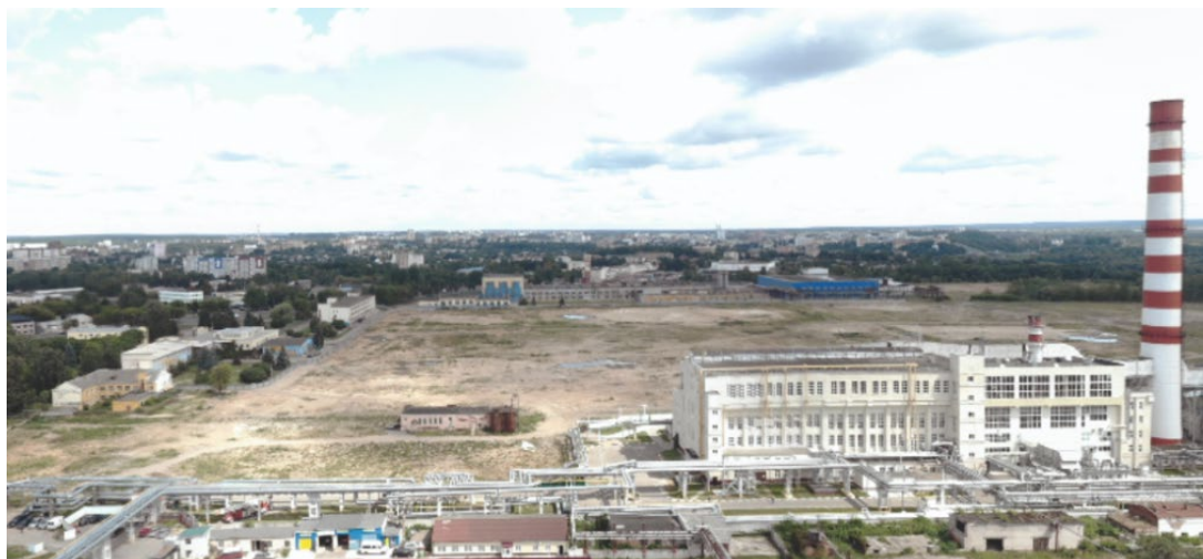
Рисунок 3.3 – Фото производственной площадки объекта
