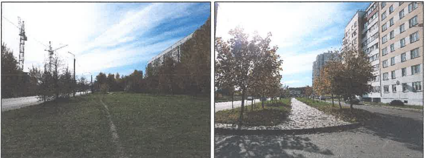
Рисунок 2.4 – Современное состояние участков прохождения трассы сетей водоснабжения вдоль ул. Жемчужной
